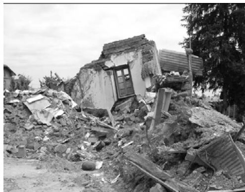
Фиг. 1. Разрушени от наводнението къщи в с. Бутово, Великотърновско Fig. 1. Destroyed by flooding houses in the village of Butovo, Veliko Turnovo
